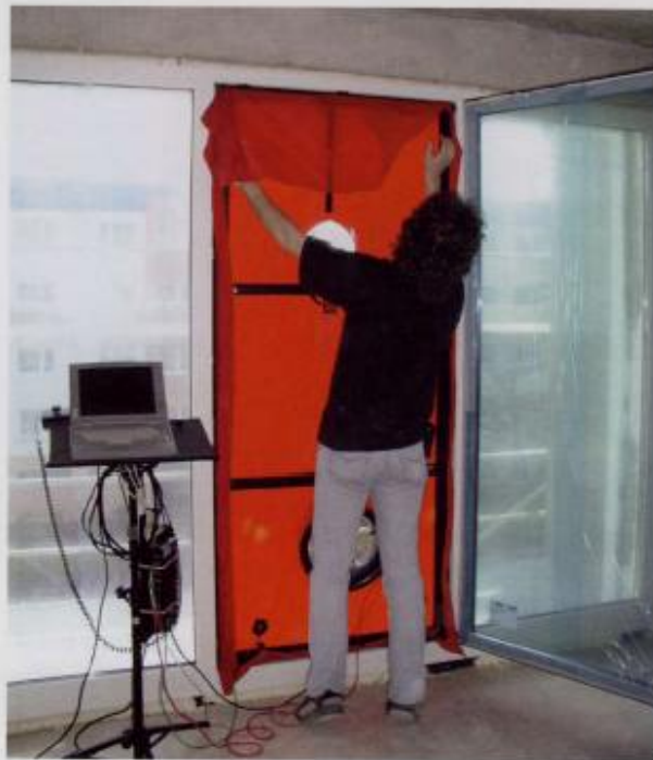
Bild 4-54 Einbau einer Blower Door in den Rahmen einer Balkontür (IEMB/BBP)
